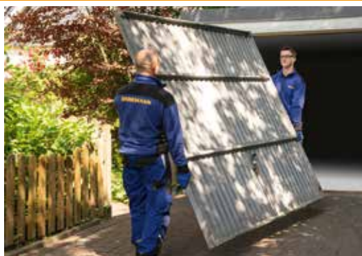
Ausbau und umweltgerechte Entsorgung
