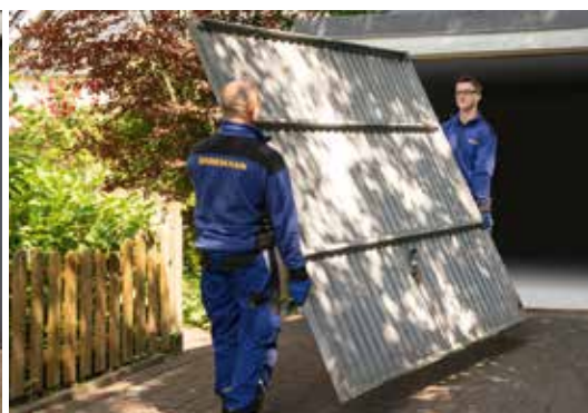
Ausbau und umweltgerechte Entsorgung
